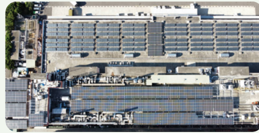
中壢廠太陽光電與太陽能熱水系統空拍圖面 495KW 太陽能光電與 100 噸太陽能熱水系統
