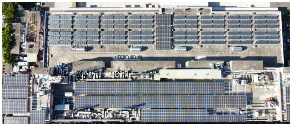
① 中壢廠太陽光電與太陽能熱水系統空拍圖面 (495KW 太陽能光電與 100 噸太陽能熱水系統)
