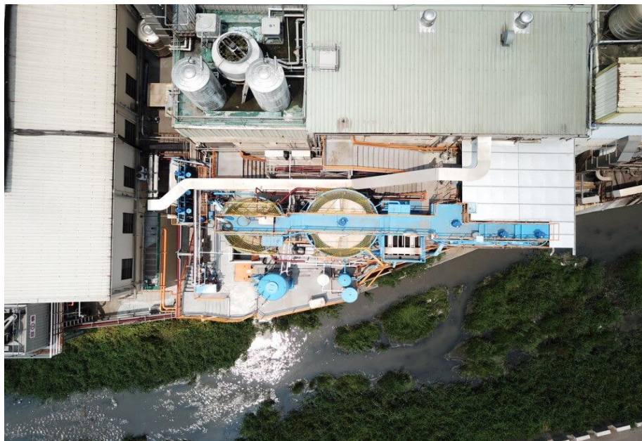
(2019 年：鮮食彰化廠完成污水處理設備整建工程)
