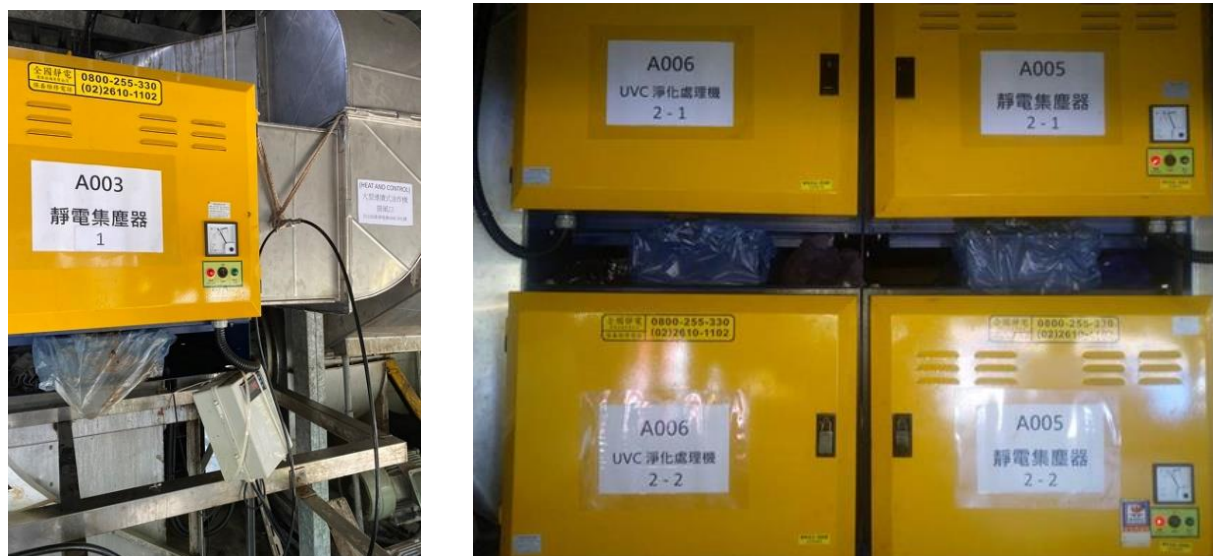
(2019 年：鮮食基隆廠增設靜電集塵器及 UVC 淨化處理機等空汙防制設備)
